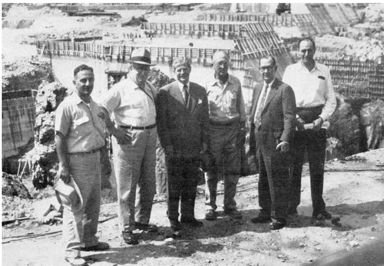
Inspeção nas obras de construção do Aproveitamento Hidrelétrico do Peixoto pelo presidente e vice da Amforp, Henry Sargent e G. O. Hylander, em 1955. Acervo da CPFL.
